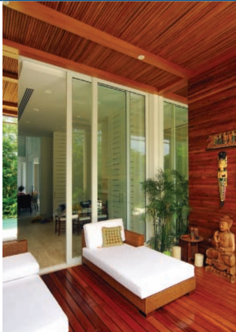
Varanda com vidro acústico laminado com resina (4 mm + 1,5 mm + 5 mm): ganho médio de 40 dB é vantajoso para ambientes de descanso
