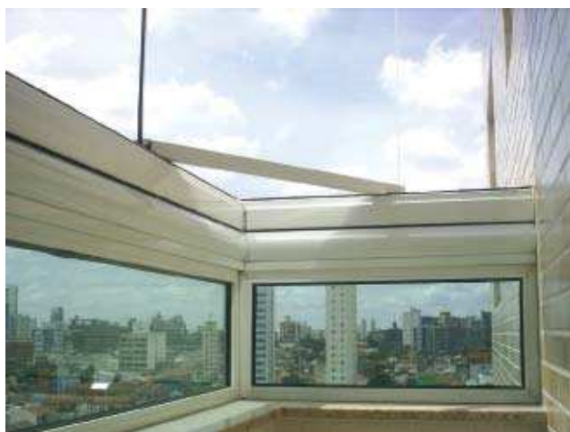
Painéis deslizam por meio de movimentos articulados entre trilhos de alumínio
