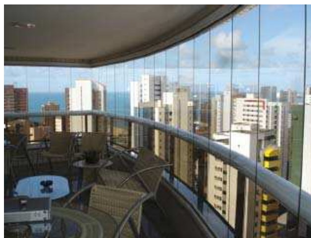
Aplicação de vidros laminados e insulados em sistemas de envidraçamento vem sendo testada
